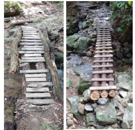
作業前(柳谷川の架橋) 作業後
